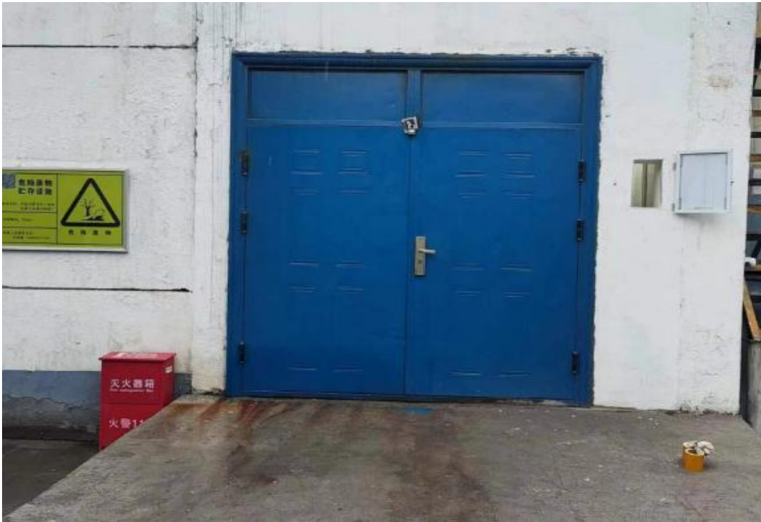
危废库外部图
