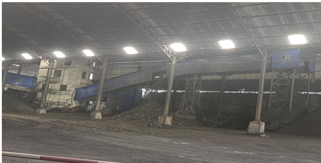
皮带筛分区输煤廊道
